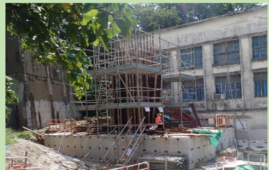
橋墩建造工程 Bridge Pier Construction
