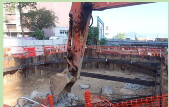
升降機塔工程 Lift Tower Construction
